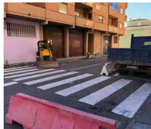
📍 Obras en ejecución en la calle Soneja
