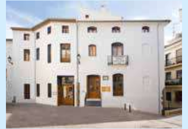
Edificio Belluga, situado en la plaza de la Belluga de Segorbe
