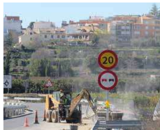
Trabajos de construcción del puente para unir la senda peatonal
