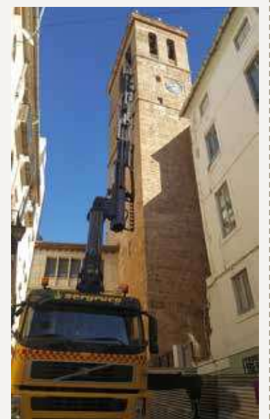
Ⓐ La grúa que realizó las labores para bajar los cabezales
