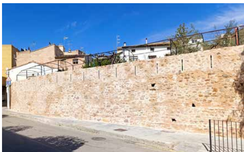
Muralla de la avenida Sierra Espadán
