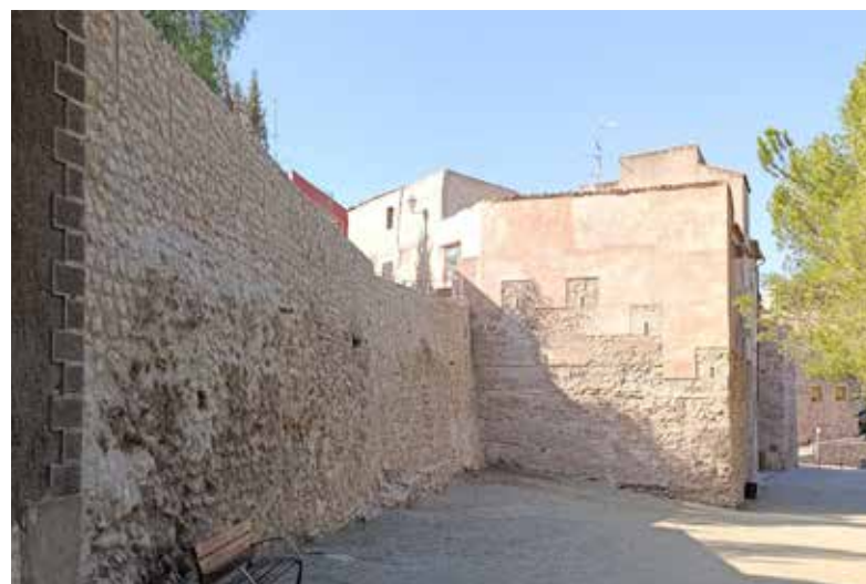
Aspecto de la muralla ya restaurada en la entrada a Sopena tras el derribo de los pajares que la ocultaban
